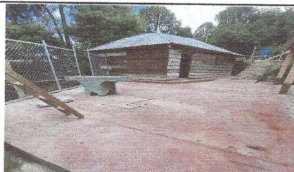
Foto 6: Finalización de la sustitución de piso de torta de concreto de 8 cm de espesor
