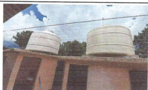
Foto 4: Finalización de instalación de depósito de agua
