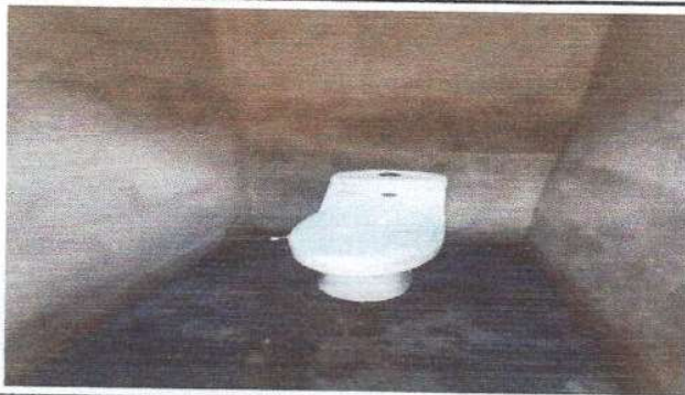
Foto 3: Finalización de sustitución inodoro
