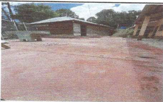
Foto 5: Finalización de la sustitución de piso de torta de concreto de 8 cm de espesor
