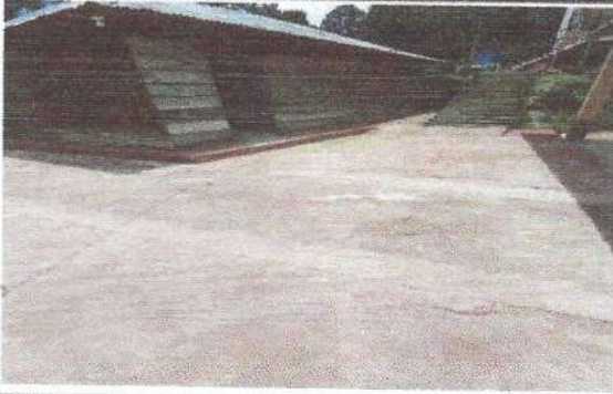
Foto 1: Finalización de la sustitución de piso de torta de concreto de 8 cm de espesor
